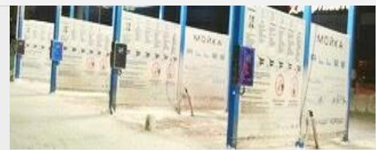
Ворота автомойки подъемно-секционные, 40 мм толщина пенополиуретанового наполнителя, 2750x2390 мм с внутренней задвижкой. Пружина, держатели роликов и петли дополнительно окрашены порошковой краской для более долговечной работы в агрессивной среде автомойки - 3 комплекта.
