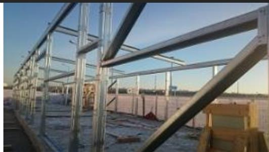
Зашивка каркаса сэндвич панелями или проф. листом с утеплением, пароизоляцией в два слоя с фасонными элементами снаружи, закрывающими стыки и углы, крепежом, пеной и силиконом. Получить отдельно стоимость зашивки по цене производителя на этот проект, [здесь](#).
