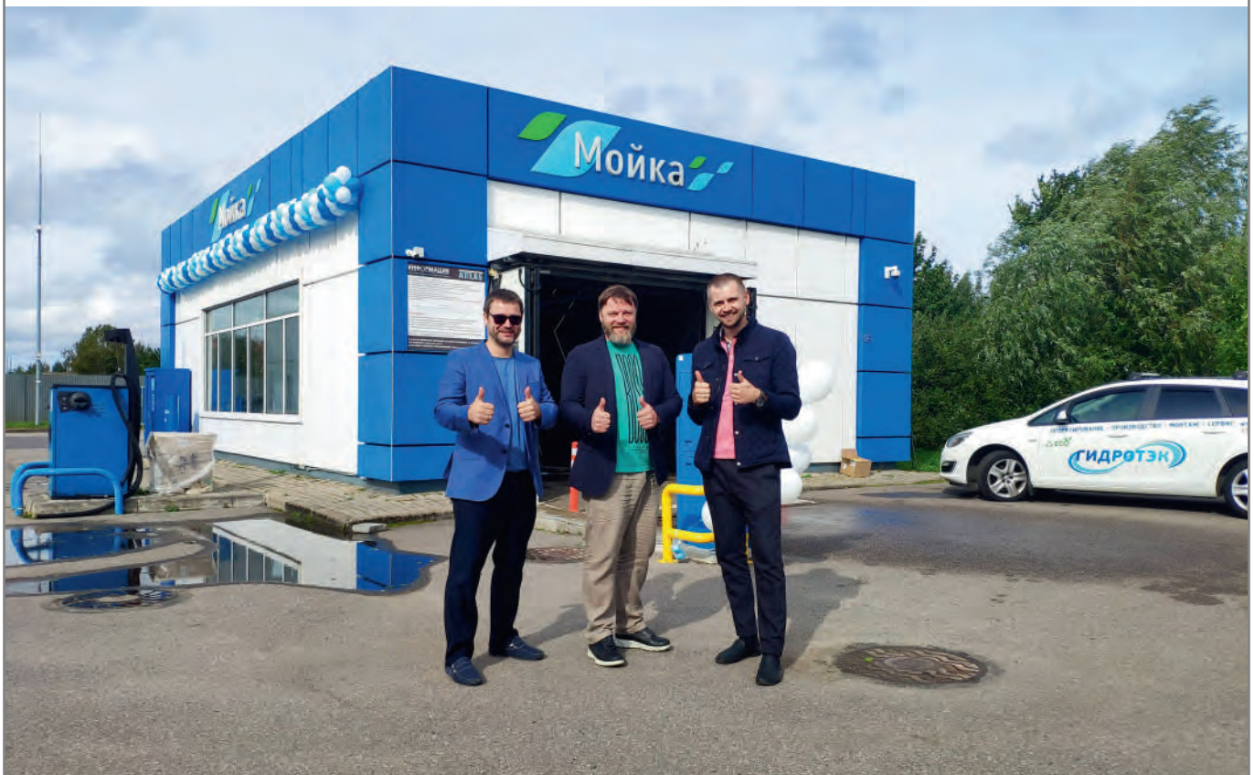
Санкт-Петербург, Кронштадт, АЗС «Газпромнефть», мойка-робот на 1 пост, 2020 год
