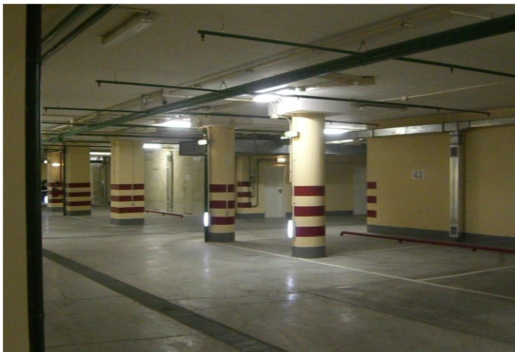
Рисунок 20 – Разводка сети автоматического пожаротушения в автостоянке
