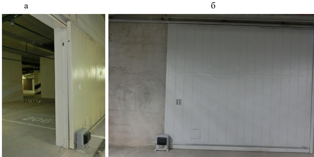
Рисунок 3 – Устройство противопожарных ворот между пожарными отсеками стоянки автомобилей с приводом:
