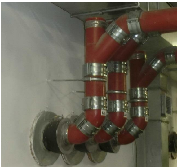
а – устройство канализационных выпусков в наружных стенах стоянки автомобилей, б – узел прохода чугунных трубопроводов через противопожарные преграды
