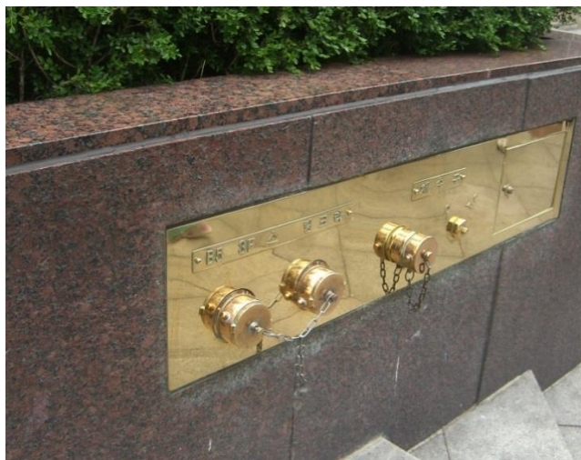
Рисунок 22 – Пример установки соединительных головок снаружи здания
