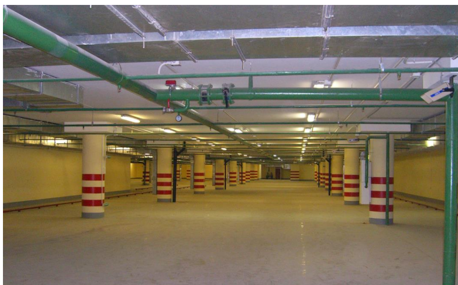
Рисунок 1 – Общий вид закрытой подземной стоянки автомобилей с
