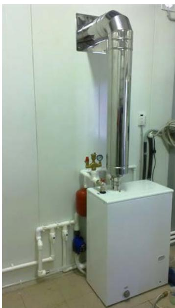
В Китурами (KITURAMI) серии STSO тело котла выполнено из нержавеющей стали. Важно отметить компактность котлов KITURAMI моделей 13 — 21 серии STSO, данный фактор может существенно упростить монтаж в ограниченном пространстве.
